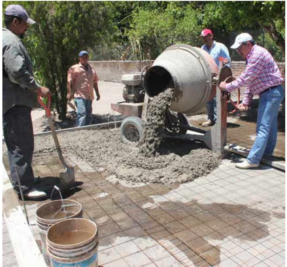
Rehabilitación de cancha en Puerta de Barro
