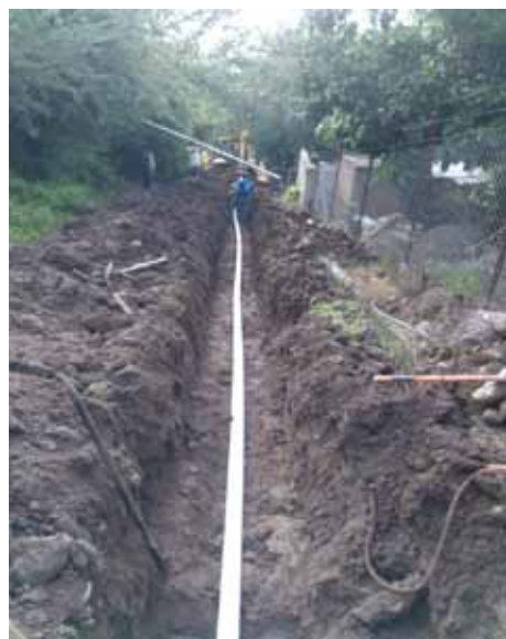
Ampliación de la red de drenaje
