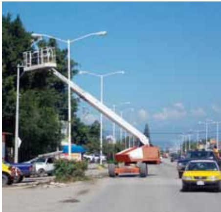
Reparación del alumbrado
