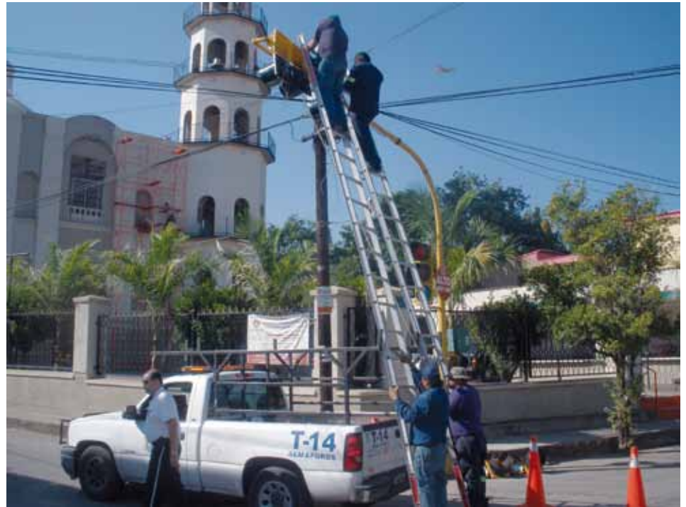
Reparación de Semáforos
