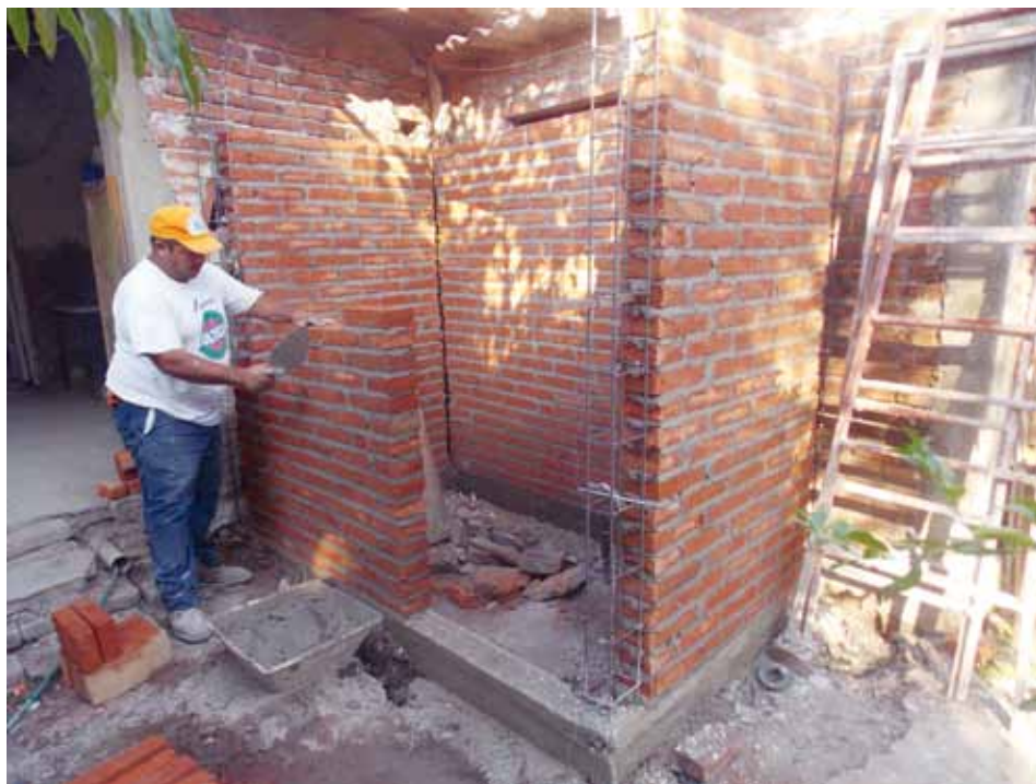
Construcción de baños
