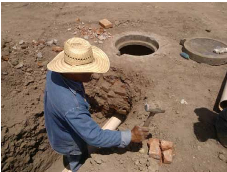
Mantenimiento a la red de drenaje
